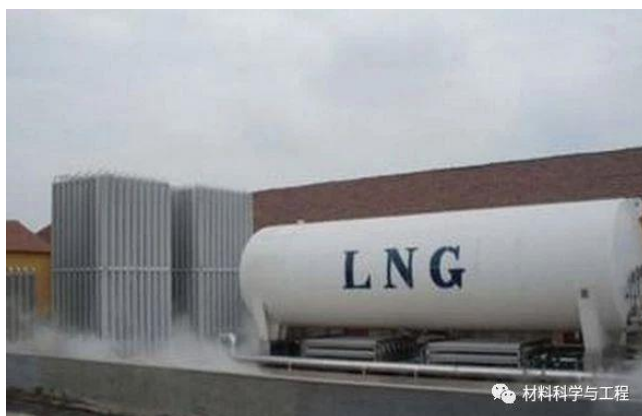
图 1 液化天然气储罐
